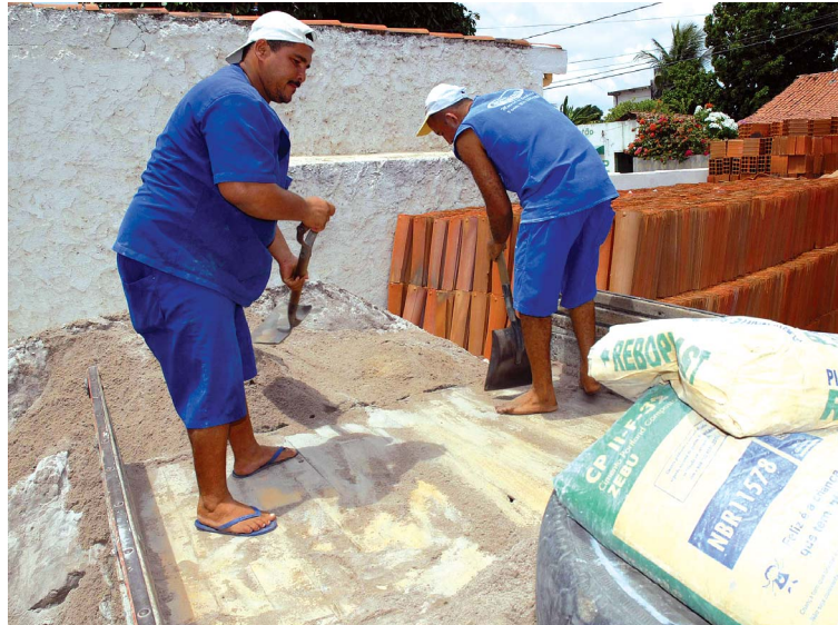
Saca de cimento já pode ser encontrada por até 10,53% mais barata
